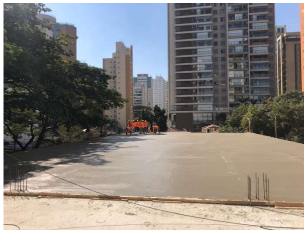
Figura 17 - Segundo trecho de laje do segundo pavimento concretado (Fonte: Acervo Obras Rápidas).
