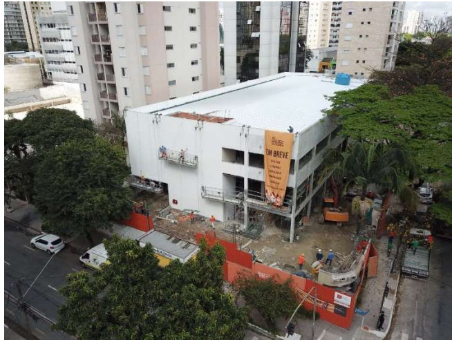
Figura 25 - Vista do canteiro de obras durante o oitavo sprint (Fonte: Acervo Obras Rápidas).
