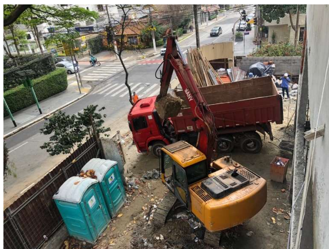
Figura 27 - Remoção de terra durante o oitavo sprint (Fonte: Acervo Obras Rápidas).
