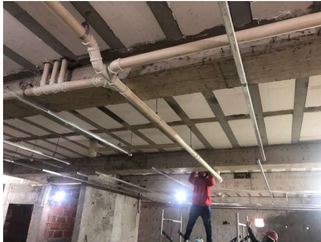
Figura 19 - Execução de tubulações hidráulicas (Fonte: Acervo Obras Rápidas).
