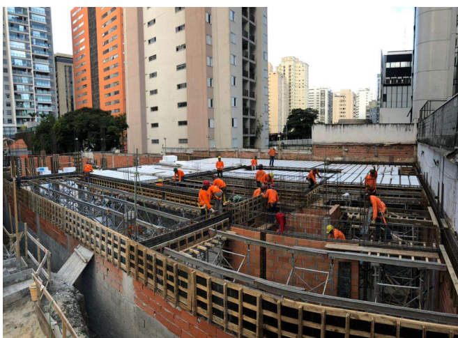
Figura 11 - Montagem de fôrmas de vigas e painéis da laje do mezanino (Fonte: Acervo Obras Rápidas)
