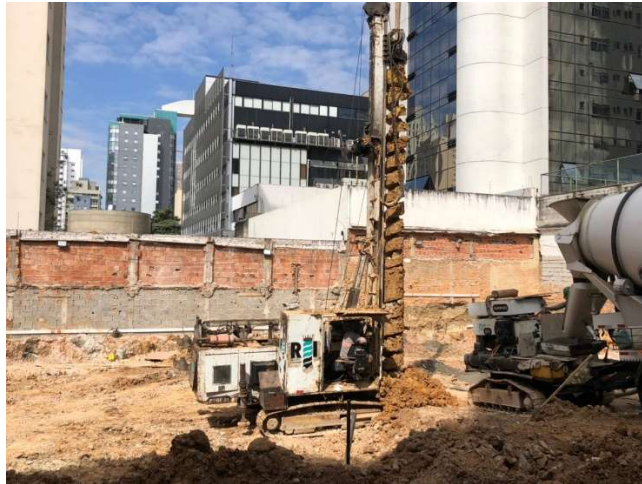
Figura 13 - Perfuração de estaca do tipo hélice contínua (Fonte: Acervo Obras Rápidas).
