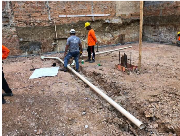
Figura 16 - Execução de rede de esgoto enterrada (Fonte: Acervo Obras Rápidas).
