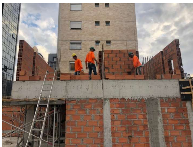
Figura 18 - Levante de alvenaria da cobertura (Fonte: Acervo Obras Rápidas).
