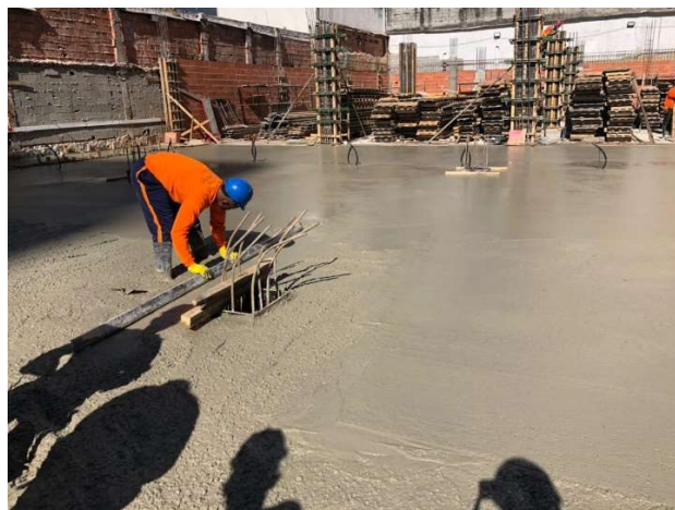
Figura 18 Concretagem da segunda etapa do piso do pavimento térreo (Fonte: Acervo Obras Rápidas).
