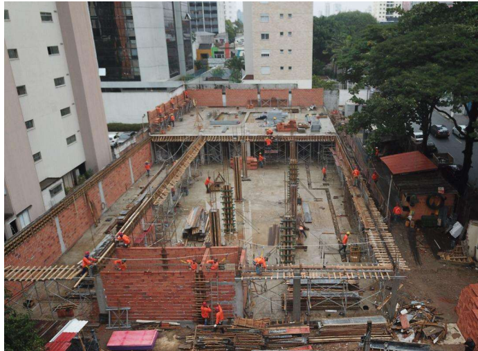
Figura 13 - Vista do canteiro de obras durante o quarto sprint (Fonte: Acervo Obras Rápidas).
