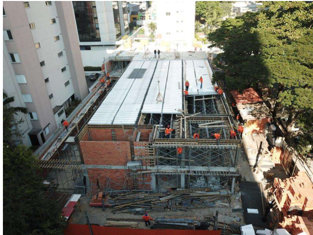
Figura 16 - Vista do canteiro de obras durante o quinto sprint (Fonte: Acervo Obras Rápidas).
