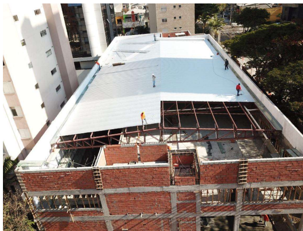
Figura 22 - Vista do canteiro de obras durante o sétimo sprint (Fonte: Acervo Obras Rápidas).
