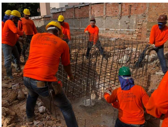
Figura 15 - Posicionamento de armadura de bloco de fundação (Fonte: Acervo Obras Rápidas).
