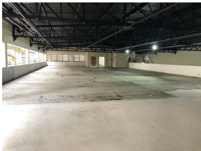
Figura 29 - Vista do estacionamento durante o nono sprint (Fonte: Acervo Obras Rápidas).
